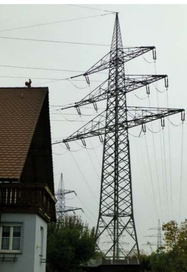
Ca. 65 m hoher Strommast bei Raitersaich. Die HGÜ-Masten sind noch 10 m höher!
